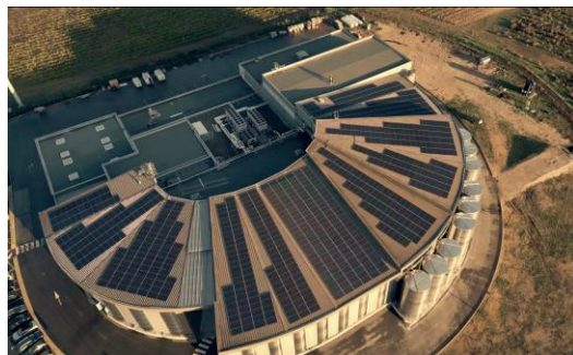
Vue aérienne de la cave Héracles avec les 864 panneaux photovoltaïques
