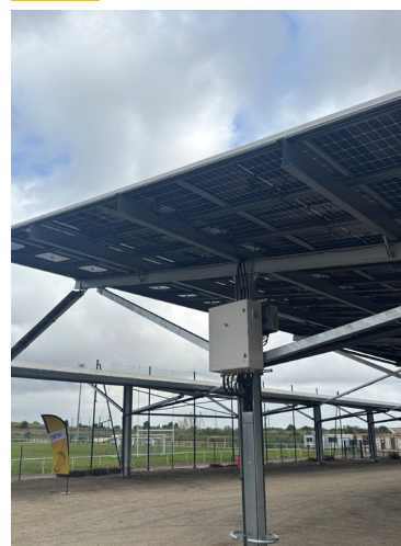
Sous face des panneaux avec cellules bifaciales pour l'optimisation de la production
