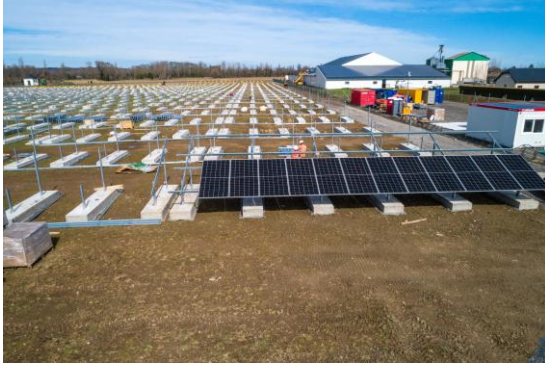
Phase de travaux
