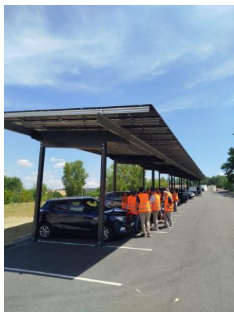
Ombrière sur parking
