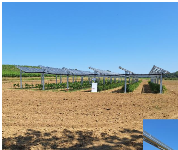
Installations sur site
